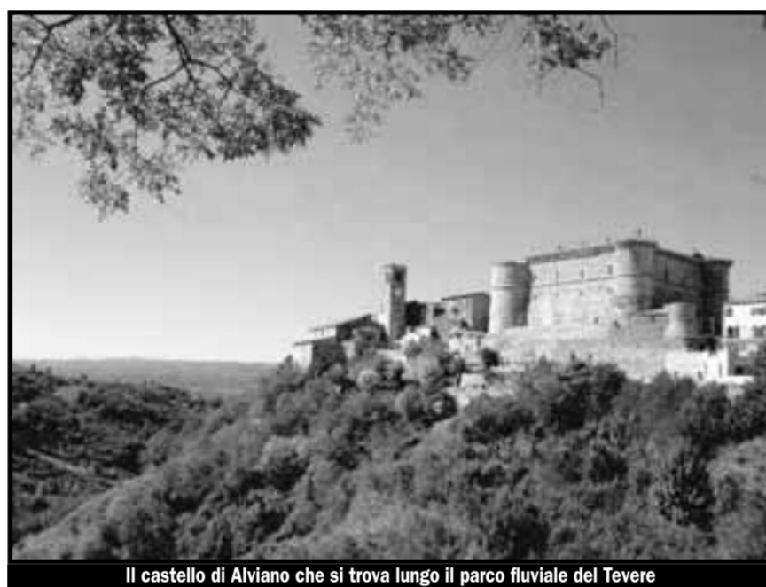
Il castello di Alviano che si trova lungo il parco fluviale del Tevere
